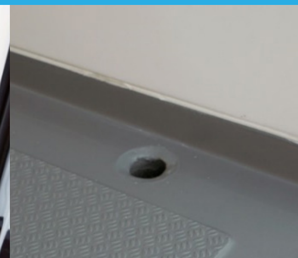
Detalle del desagüe situado en la parte delantera derecha dentro del canal perimetral
